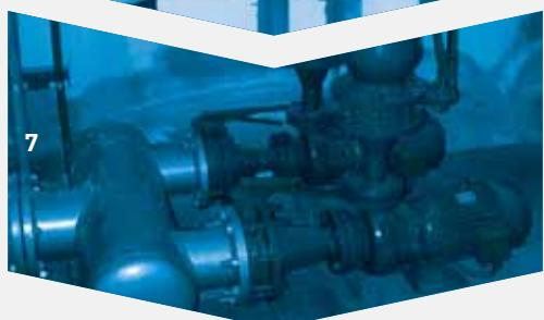
Il controlavaggio in quattro fasi dei filtri a sabbia avviene periodicamente in base alla torbidità in ingresso: svuotamento; insufflazione d'aria; circolazione inversa di aria e acqua e quarta fase con circolazione inversa di sola acqua.
